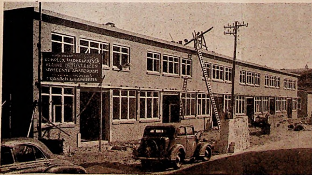
Opgetrokken als stalen skelet met metselwerk en houten ramen.
