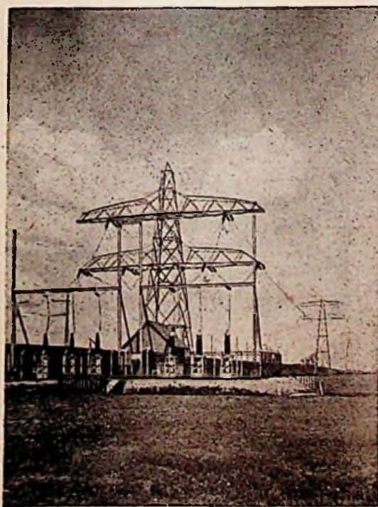
De overgangsplaats van een bovengrondse dubbelcircuitlijn voor 150 kV op zes één-phase kabels, waarin de grote afmetingen van de 150 kV eindmoffen opvalt.
